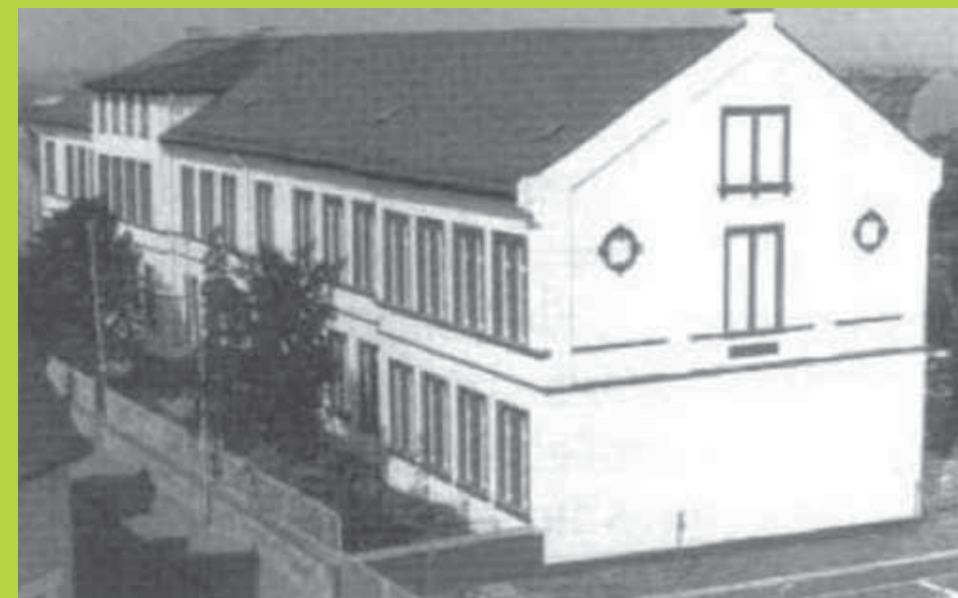
Alte Bessunger Knabenschule um 1978
